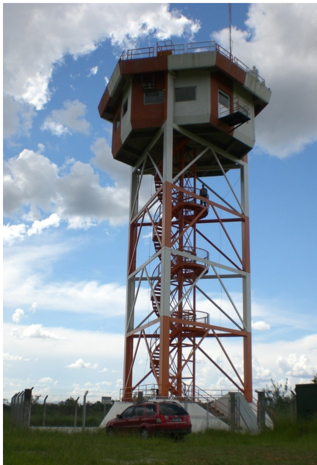
Figura 1 Torre de Observação de Descargas Atmosféricas
